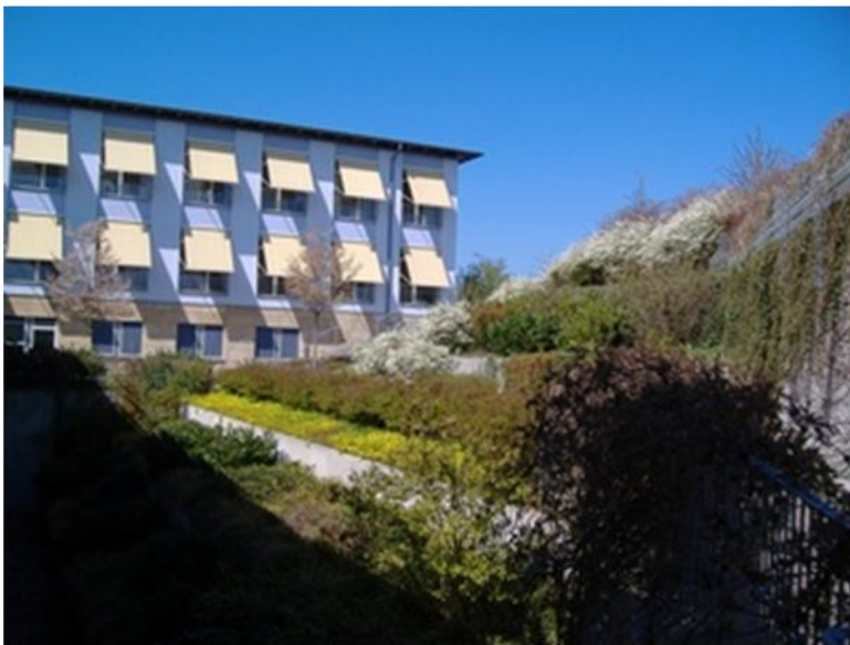
Blick auf die Patientenzimmer der Stationen 2 und 4
